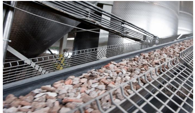
"IMPIANTO DI VAGLIATURA SOIL-WASHING"
